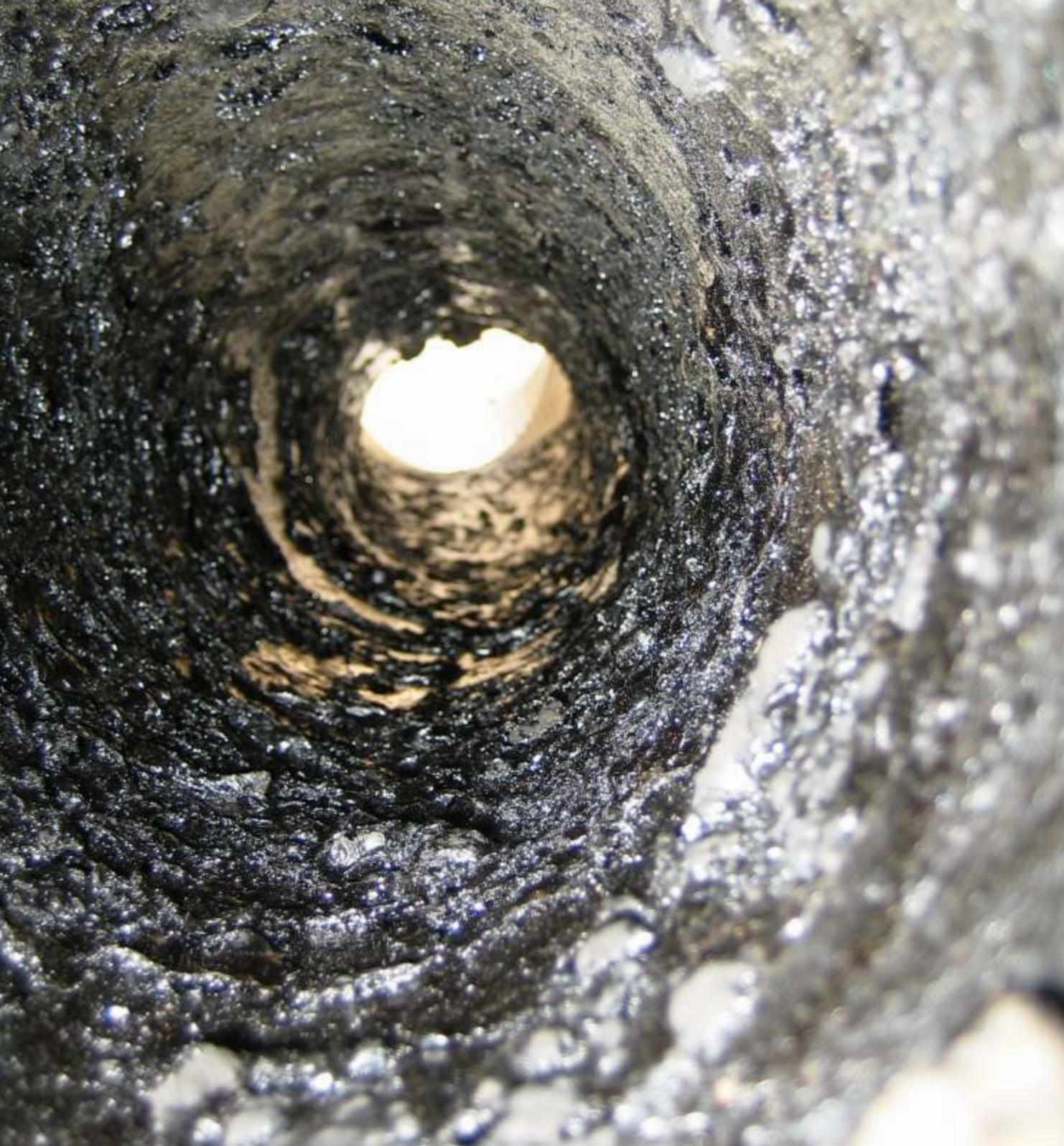
Der Ruß und andere feste Partikel, die bei der Verbrennung in Öfen, Kesseln und Schornsteinen entstehen, lagern sich an den Wänden der Rauchabführkanäle ab. Diese Ablagerungen verringern den Schornsteinzug und erhöhen den Verbrauch, da dadurch die Leistung dieser Anlagen sinkt und der Energieverbrauch steigt.
